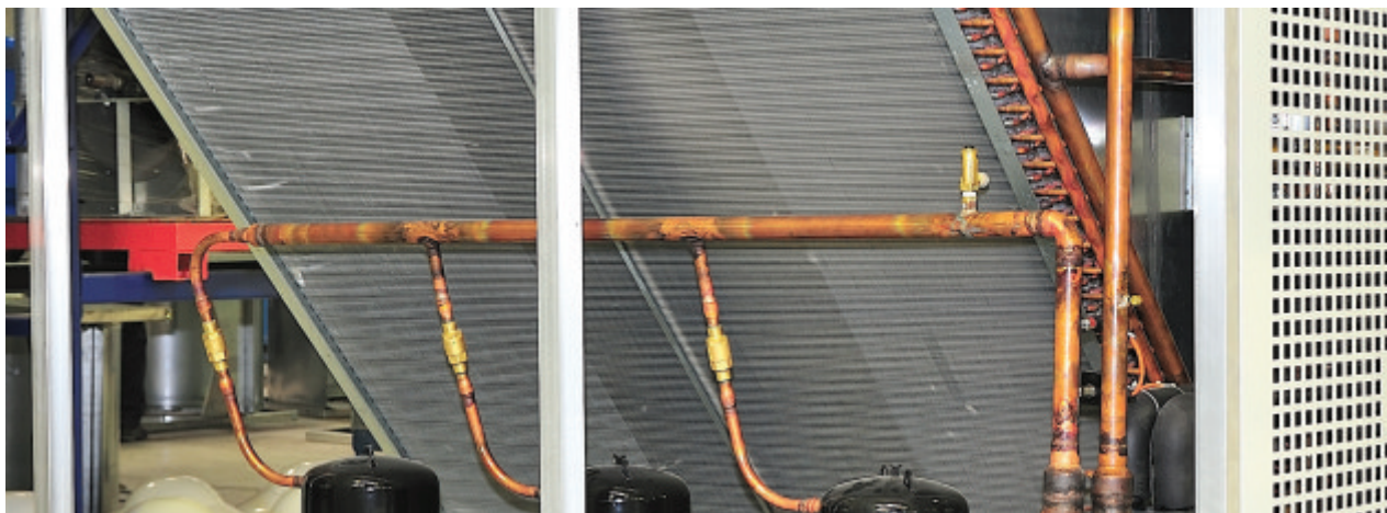
Système de condenseur à tubes en cuivre/ailettes en aluminium de type conventionnel/ Conventional type copper tubes/aluminum fins condenser system
